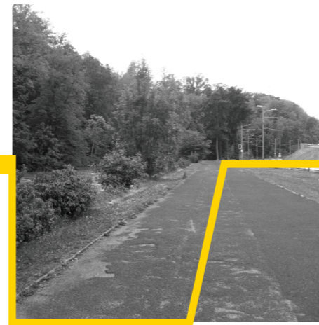
10. JARDIN DE L'AREUSE Aménagement d'une place de jeux / petit jardin public sur le thème du fil d'Areuse / banc orienté avec les falaises
